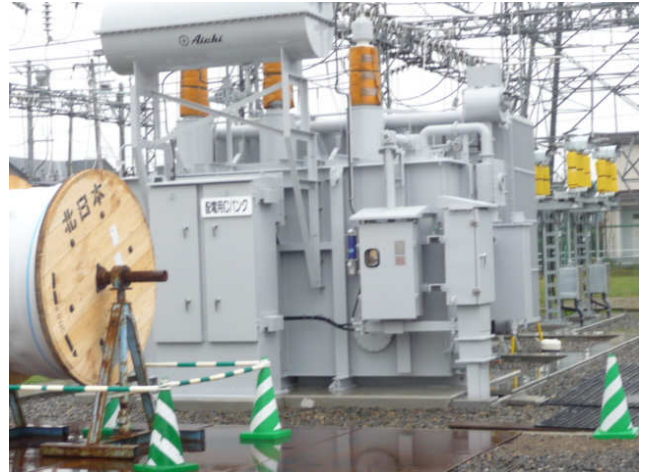
配電用Cバンク増設中
